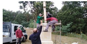
Montowanie pomnika Powstańców Wielkopolskich ufundowanego przez IPN
