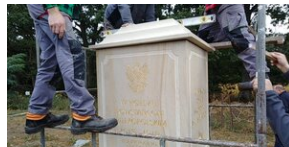
Montowanie pomnika Powstańców Wielkopolskich ufundowanego przez IPN
