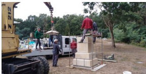
Montowanie pomnika Powstańców Wielkopolskich ufundowanego przez IPN
