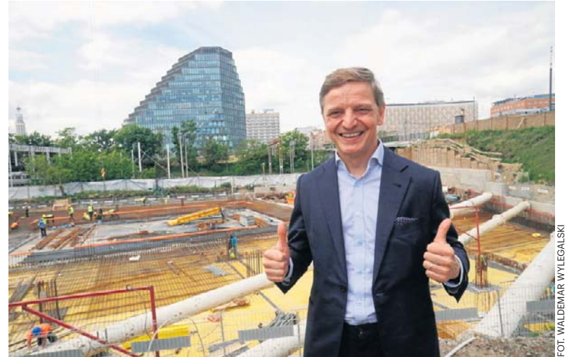
Dyrektor Teatru Muzycznego w Poznaniu przy terenie budowy nowej siedziby instytucji, która ma być oddana przed końcem 2028 roku
