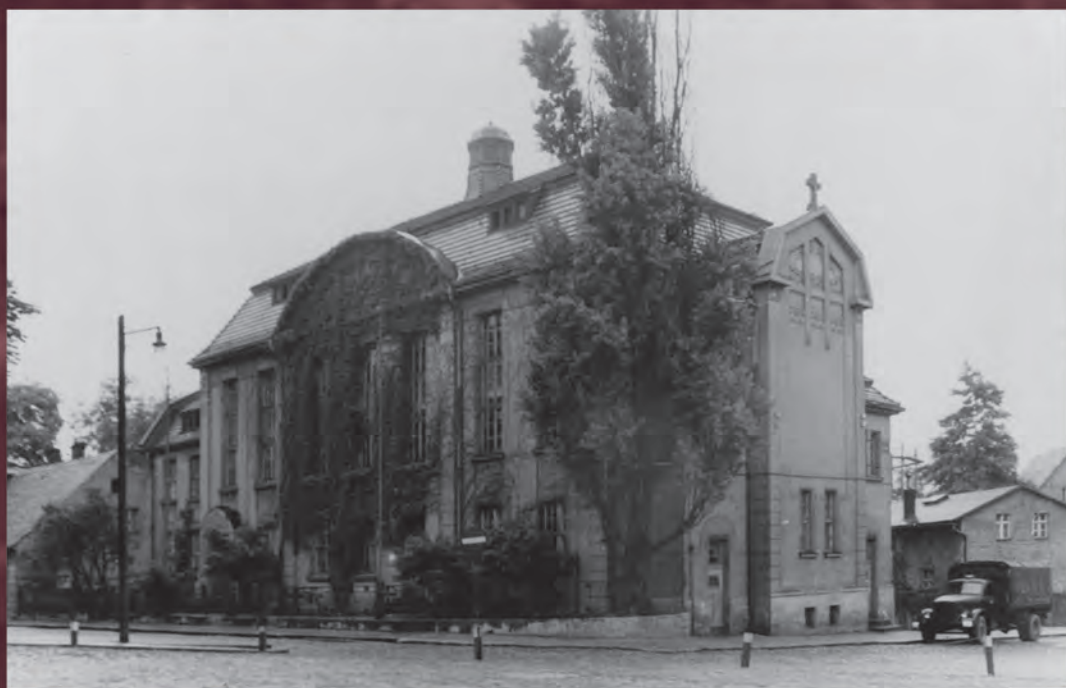
Gmach Domu Katolickiego. Fot. AIPN
